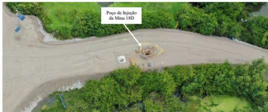
Figura 55 – Poço de injeção da Mina 18D, em imagem aérea registrada pela Perícia em 17/08/2023.
