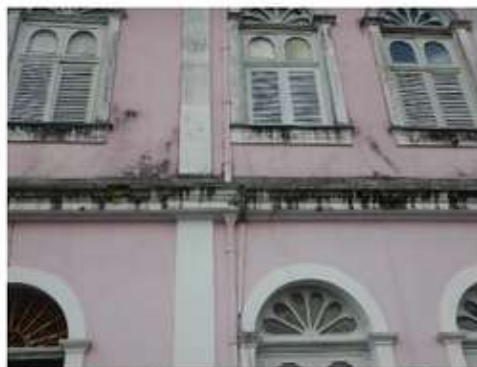
Figura 53 – Aberturas na fachada de edificação objeto de tombamento (conforme Decreto nº 38.081, de 19/07/1999).
